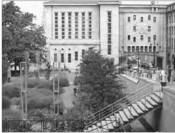
Figure 9 : Mont des Arts, présence de porches créant une rupture acoustique et conférant une atmosphère calme dans le parc
