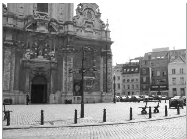
Figure 12 : place des Béguines, la place est entourée de façon homogène par des bâtiments, constituant une coupure entre le bruit de la ville et l'espace sonore créé sur la place
