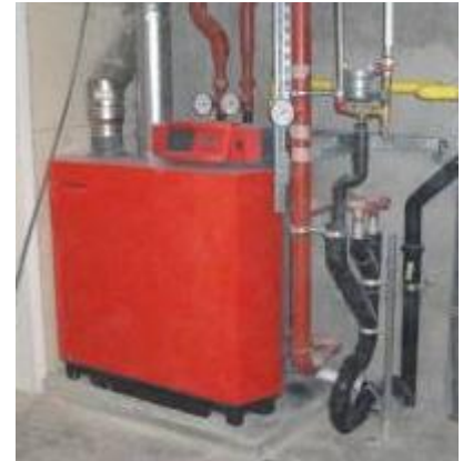
[040_Aéropolis] Source : Cenergie
