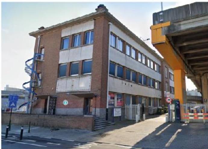
Façade orientée Nord-Est
