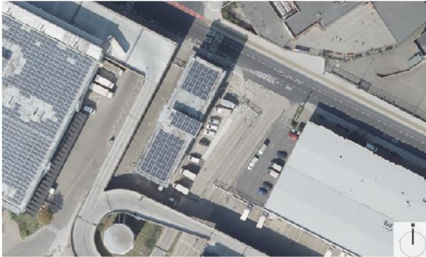
Vue aérienne de la toiture
