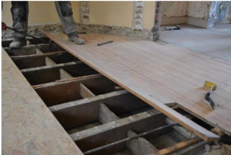
Démontage préservant du plancher, en vue de son réemploi comme sol du +3
