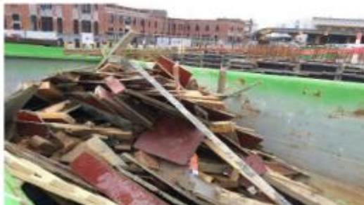
AVANT intervention du gardien de chantier
