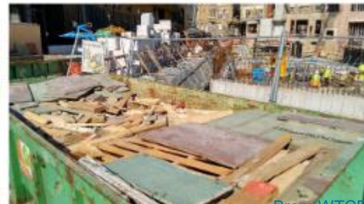
APRES intervention du gardien de chantier
