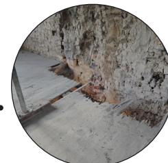
Sluiting van bestaande schoorsteenschachten met vloerplanken van nieuwe schachten
