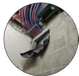
Collector bereikbaar via toegangsluik
