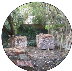
Bakstenen van de afbraakwerken worden hergebruikt om de borstweringen te verhogen en het bestaande te herstellen
