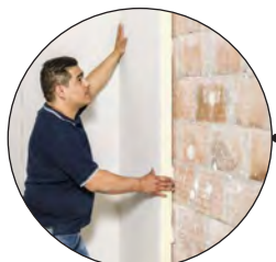
PIR (opgeblazen met pentaan) met gipsplaat
