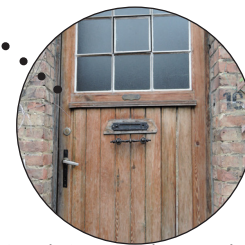
Bestaande toegangsdeuren gebruikt als buitendeur
