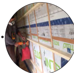
Isolatie uit ingeblazen cellulose met Natureplus-label
