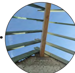
Gebinte en skelet van uitbreiding uit hout met FSC- of PEFC-label
