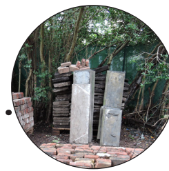
Gebruik van buitendorpels van achtergevel als vloerbekleding voor het terras
