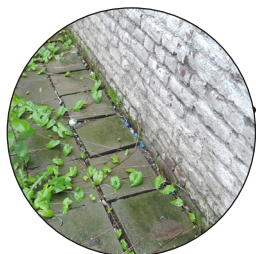
Klinkertegels van de terrassen achteraan voor de aanleg van het toegangspad
