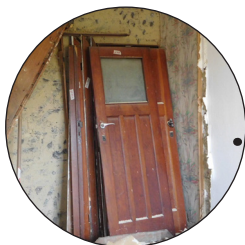
Zoveel mogelijk deuren worden na behandeling ter plaatse hergebruikt
