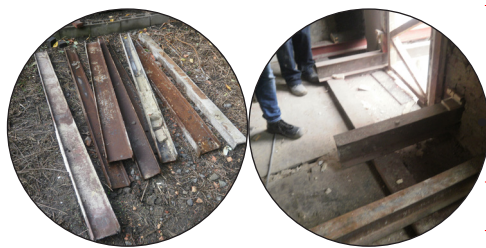
Ontmantelde stalen balken op de bouwwerf gebruikt voor stutwerk
