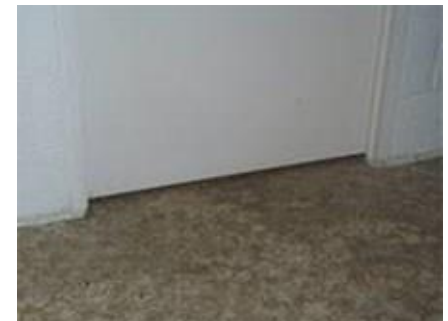
Ingekorte deur H_{\text{spleet}} \geq 5 \text{ mm}
