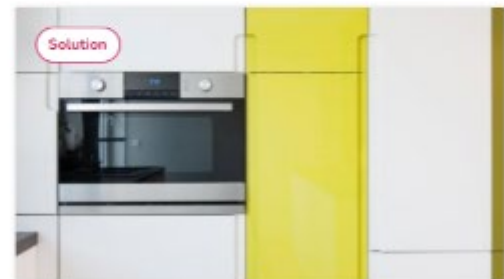
Démontage de meubles intégrés et cuisines
