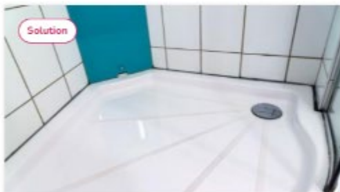
Démontage de cabines de douche et accessoires
