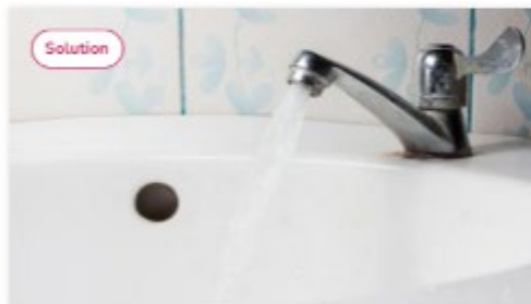
Démontage de lavabos et robinetterie
