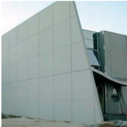
Dunne wand uit gewapend beton
