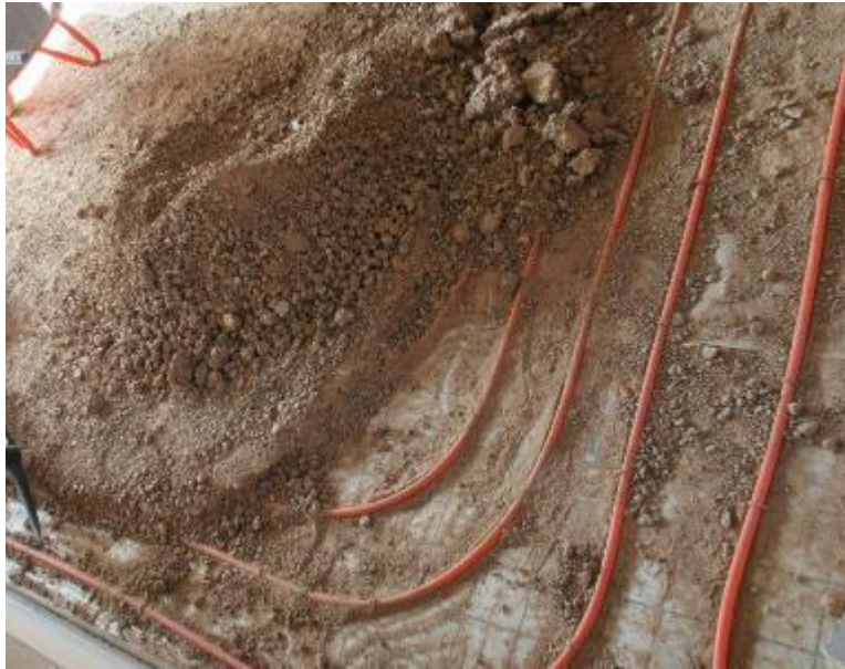
Demontage van de aarden dekvloer
