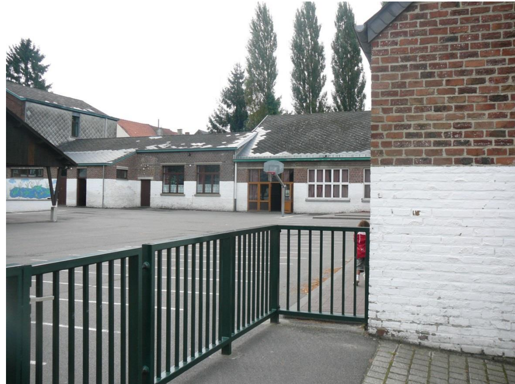
De technische staat van de bouwschil
