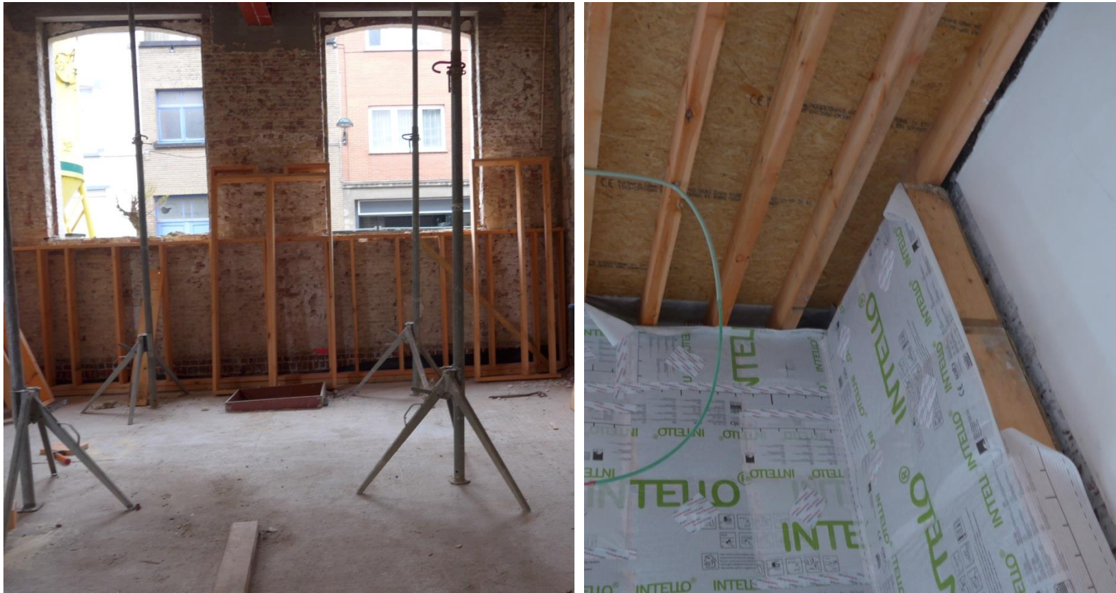
Isolatie van binnen tegenstructuur vóór gestripte structuur Plan voor luchtdichtheid
