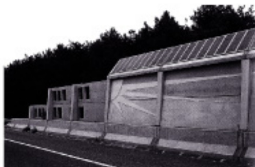
Geluidsschermen in beton
