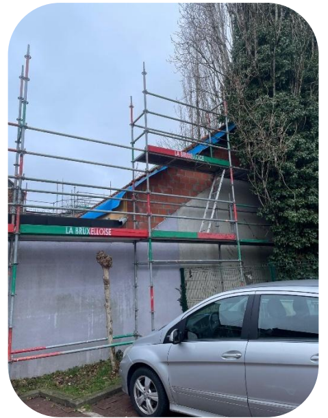
Ophoging van het bestaande volume op de bouwplaats 131_Roodebeek: minimale bezetting van de openbare ruimte
