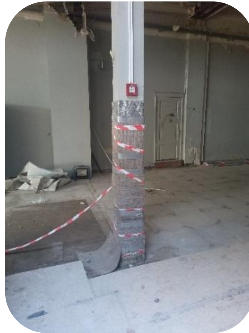
073_Poincaré Resten van vloerbedekking voor de bescherming van kolommen
