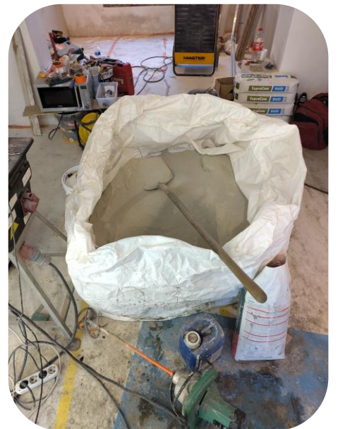
Ruw materiaal geleverd op de bouwplaats voor het aanbrengen van leempleister op de muren, werf 012_Thermotopie
