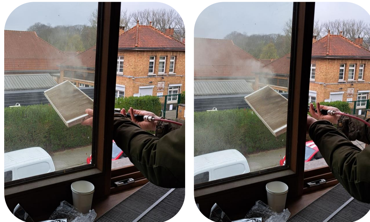
128_Gulden Bodem Reiniging van de filters van de ventilatie met dubbele flux met de compressor. De ventilatie wordt geactiveerd tijdens de droogfase van de leempleister. De filters worden aan het einde van de werken vervangen, op het moment dat de bouwheren hun intrek nemen.
