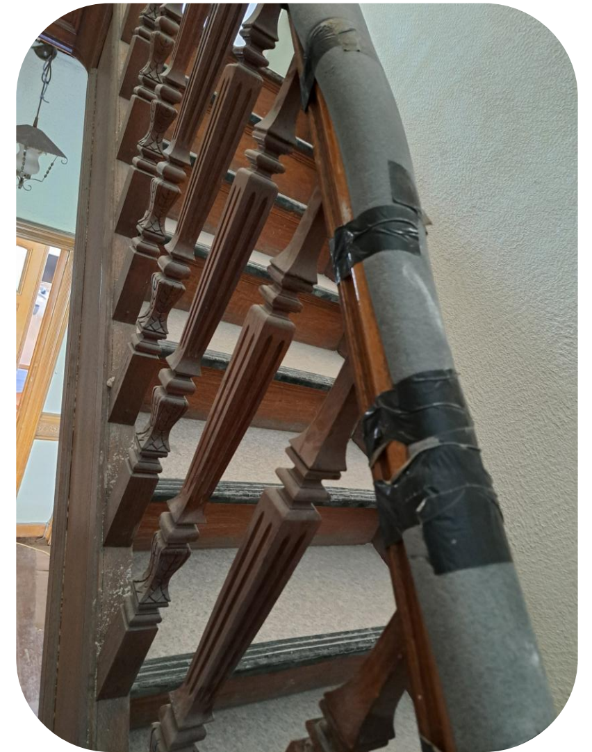
Hergebruik van isolatiekokers van leidingen als bescherming voor de trapleuningen 133_Bockstael 138
