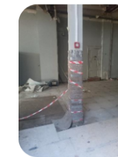
073_Poincaré Chutes de revêtement sol pour protection des colonnes
