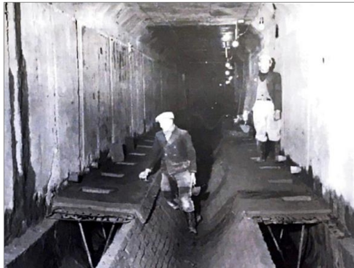
Figuur 45: Voltooiing van een deel van de overwelfing van de Woluwe in 1953 (bron: Association de coord. et. al., 1983: 42)
