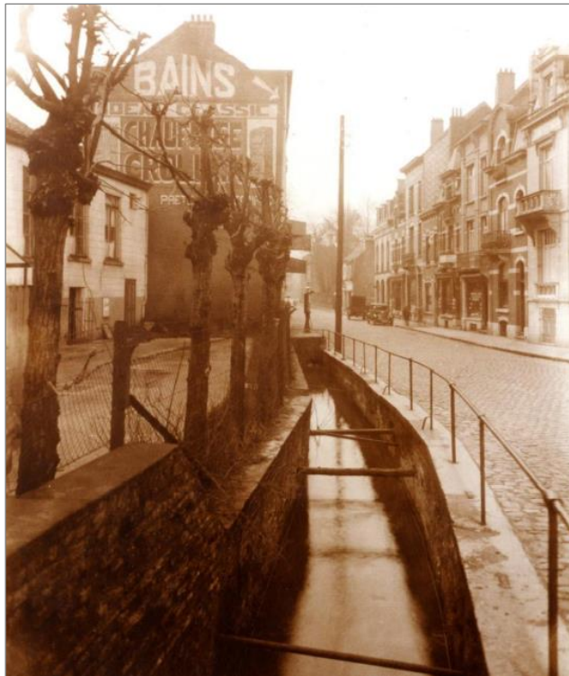
Foto 3: De Woluwe aan de Middelburgstraat voorafgaand aan de overwelfing, historische foto, Centrum Lokale Geschiedenis. Deze foto geeft ons een vrij nauwkeurig idee van de breedte van de waterloop. De Woluwe was een open riool geworden dat het afvalwater van de huizen langs de oevers verzamelde.
