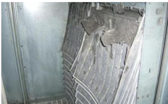
Figuur 2.5 gescheurd zakfilter
