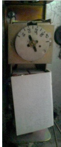
Figuren 5.2 tweewegklep op een ijswatercircuit van een ventilo-convector en het bedieningselement : de thermostaat
