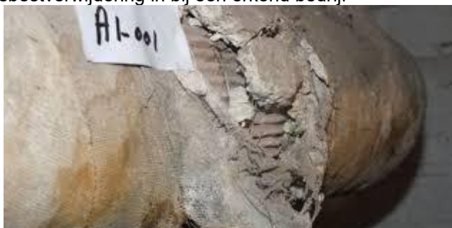
Afbeelding 8.6 - Beschadigde asbestbekleding
