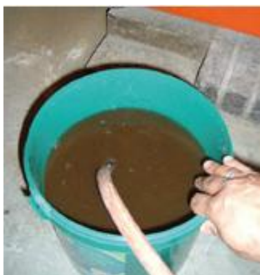
Figuur 6.2 Afzetting controleren bij het ledigen van een slibafscheider
