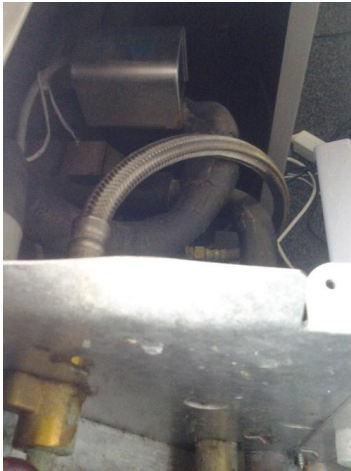
Figuren 5.2 tweewegklep op een ijswatercircuit van een ventilo-convector en het bedieningselement : de thermostaat
