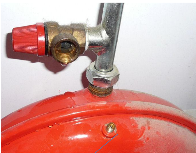
Figuur 6.1 Controle- en opzwelpunt van het expansievat (na isolatie en afzetten van de tegendruk van het water)
