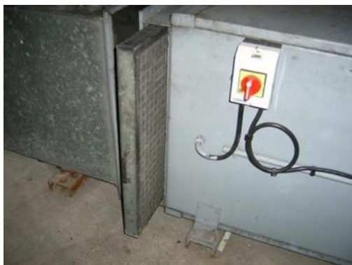
Figuur 2.4 filter visueel controleren
