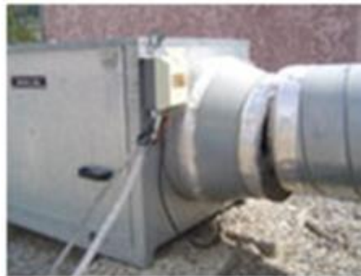
Figuur 2.1 voorbeeld van beschadigde luchtkanalen (uitgang pulsiegroep)
