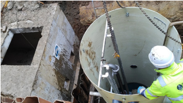
Installatie van het pompstation Kanal- Willebroek
