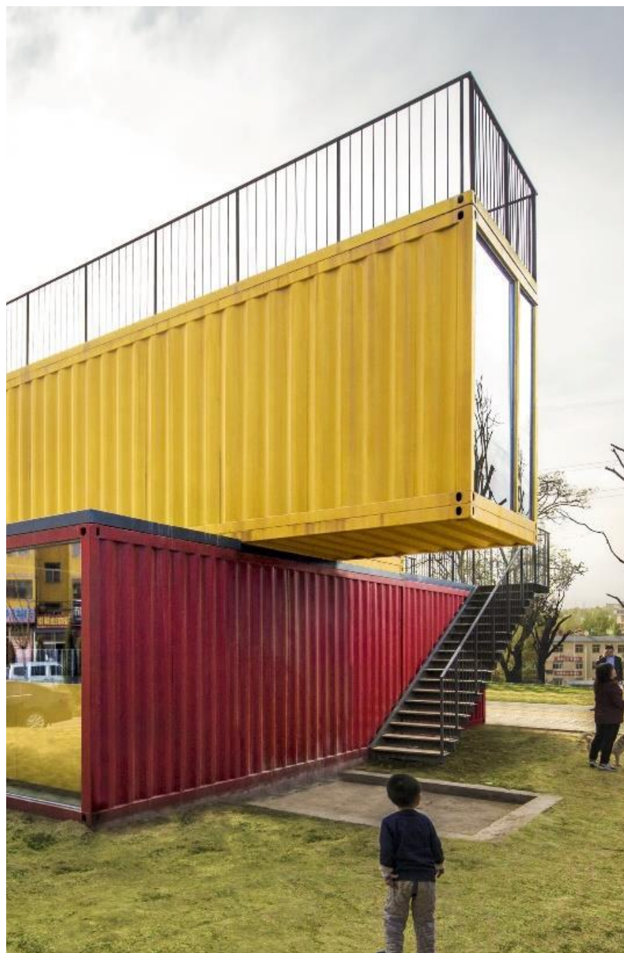
© Projet réalisé à Taiyuan, Shanxi, par le cabinet People's Architecture PAO
