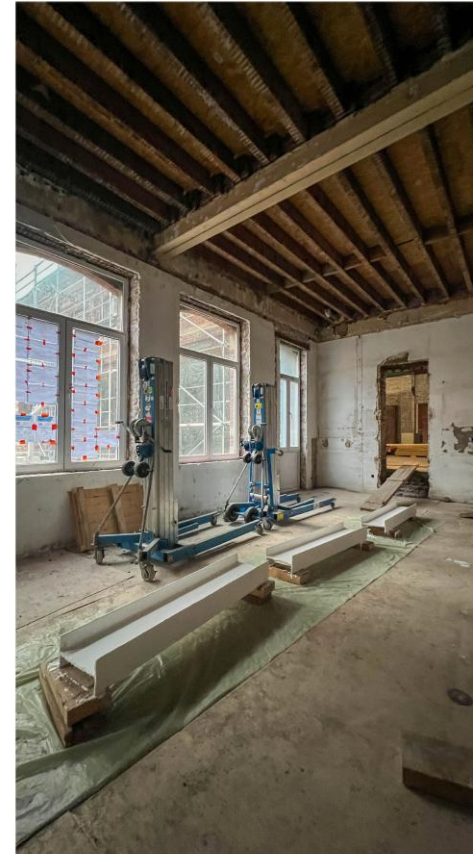
Hergebruik stalen balken
