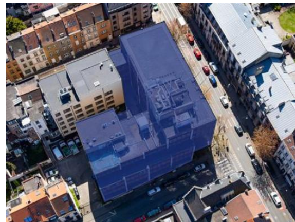
Vifquin – renovatie – 1.544 m 2
