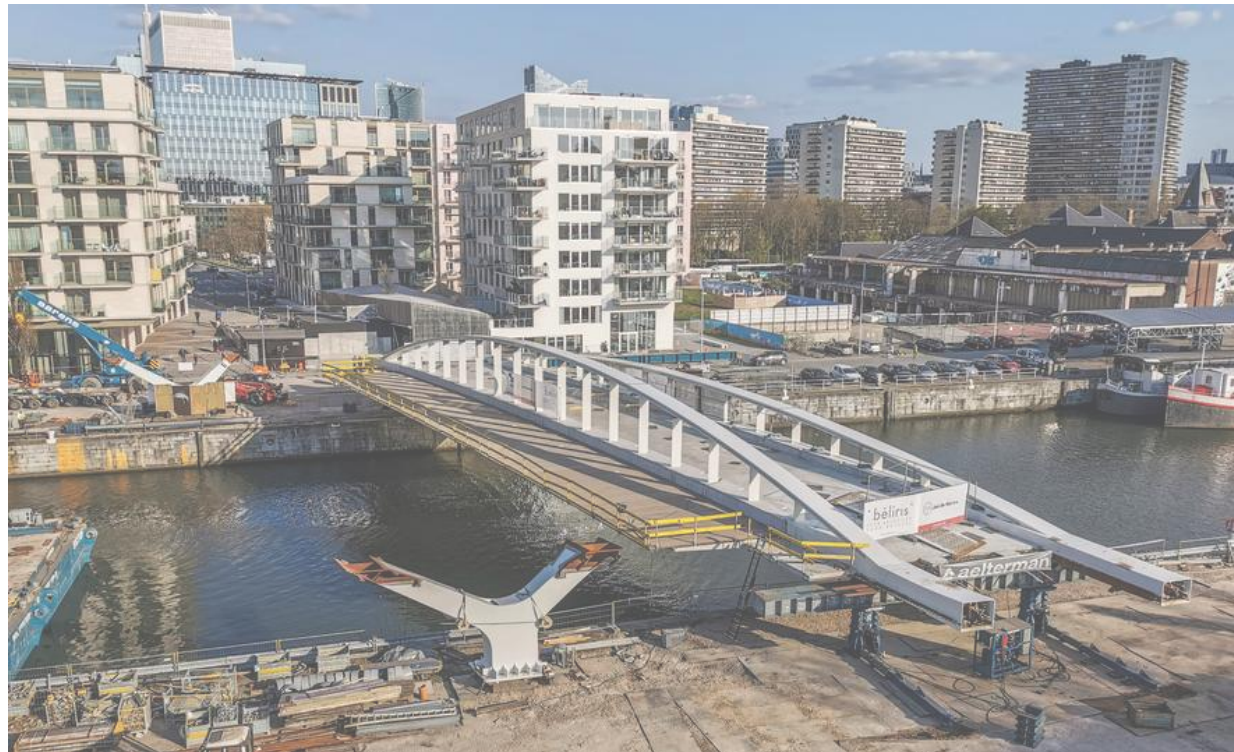
Bouw van de Suzan Daniel-brug – © Beliris
