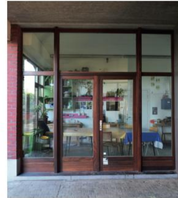
Local de quartier parc Reine-Verte - Schaerbeek
