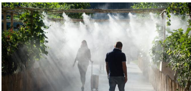
Système de brumisation (source : Adobe stock)
