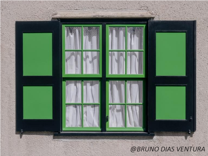
Isolatie van de raamomlijsting, bijwerking van Tiroler pleister
