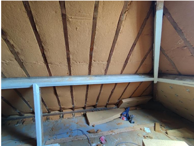
Eerste isolatielaag tussen de kepers
