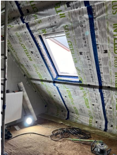
Plaatsing van de dampremmende laag aan de warme zijde
