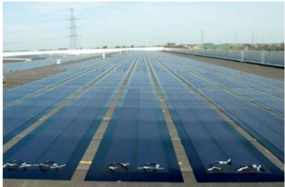
Bron: Project Colruyt
