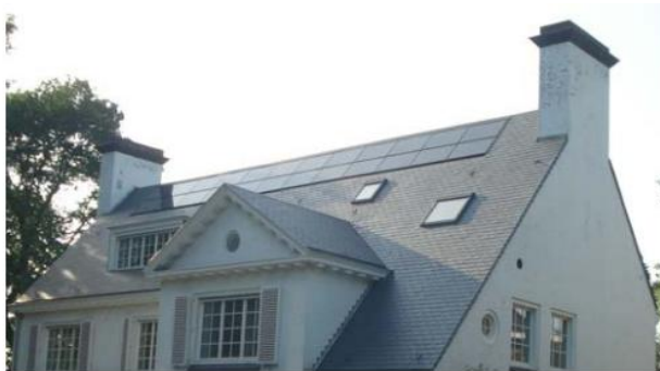
Figure 10: Modules intégrés - APERe
