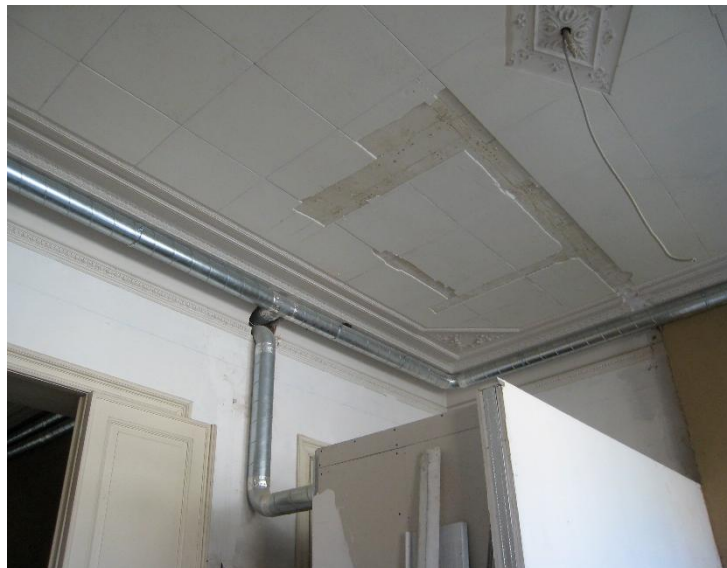
Installatie van ventilatiekanalen Bron: Philippe Abel
