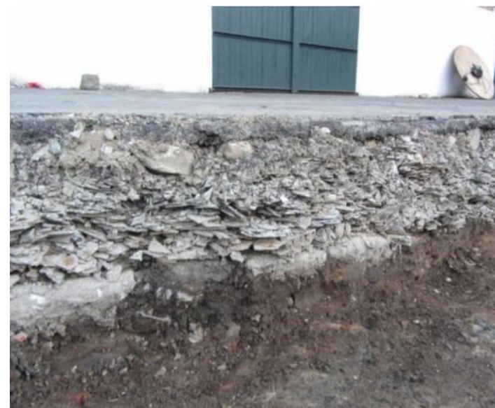
Asbeststukken in ophooglagen
