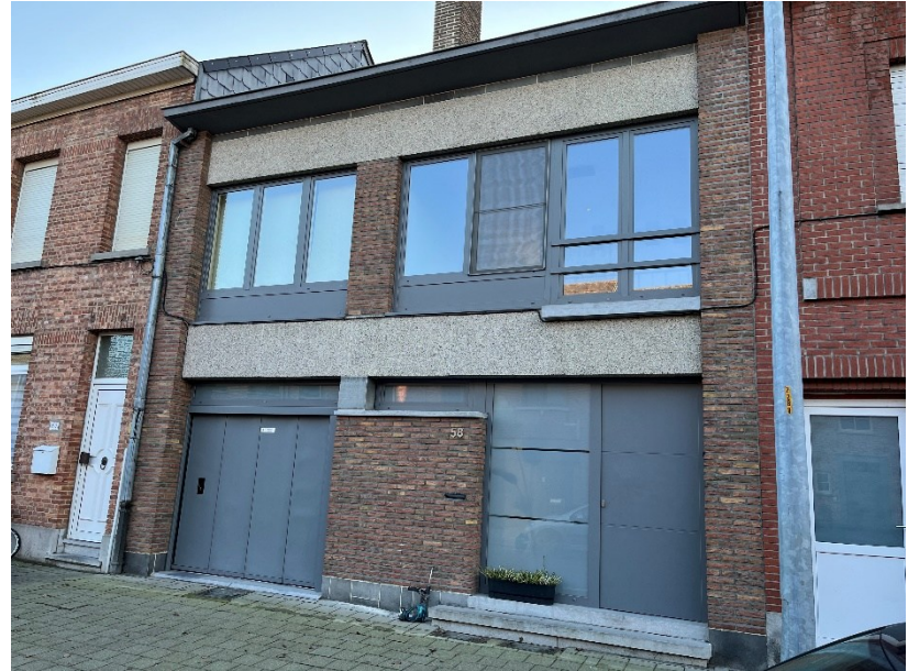
Gevel met (bijna) geen spouwmuren
