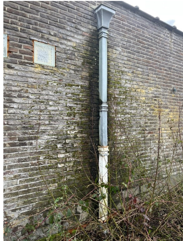
Lekkende regenwaterafvoer
