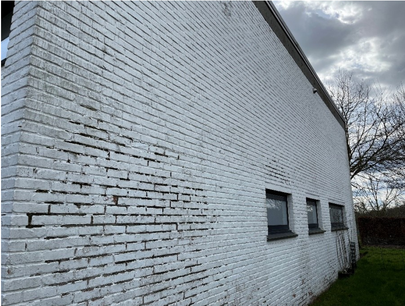
Geschilderd met afschilfering verf en algengroei
