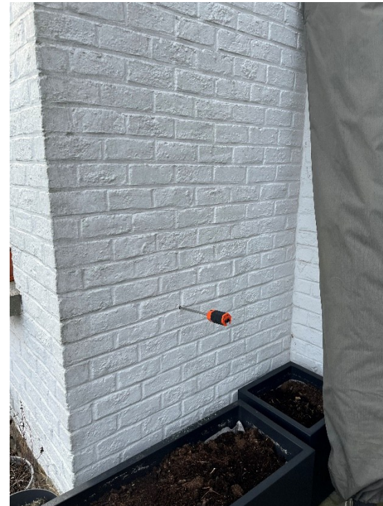
Geschilderde gevelsteen met dampdichte verf
