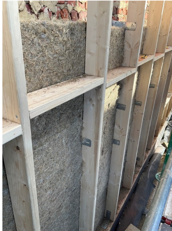
1e doorlopende laag niet-doorlopende bevestiging
