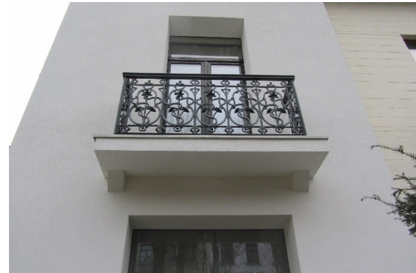
Gevel met behouden balkon - NA
