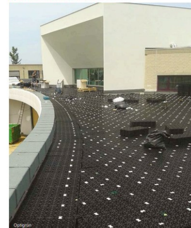
2 | Toiture à rétention d'eau en cours de réalisation.
