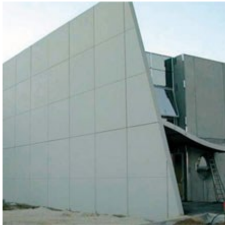
Dunne wand uit gewapend beton
