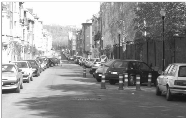
Wegverlegging met paaltjes en parkeerplaatsen in Molenbeek
