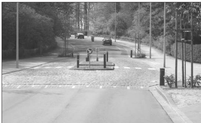
Wegverlegging door een middeneiland met voetgangersoversteekplaats in Vorst
