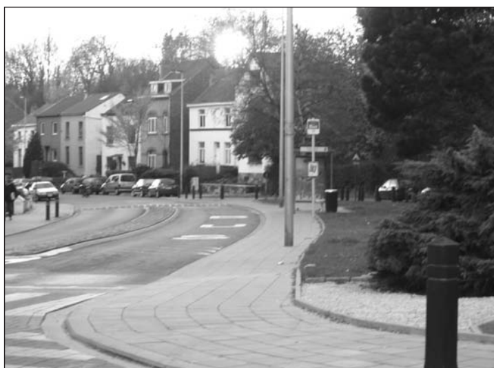
Overrijdbaar middeneiland ter hoogte van een bushalte in Ukkel
