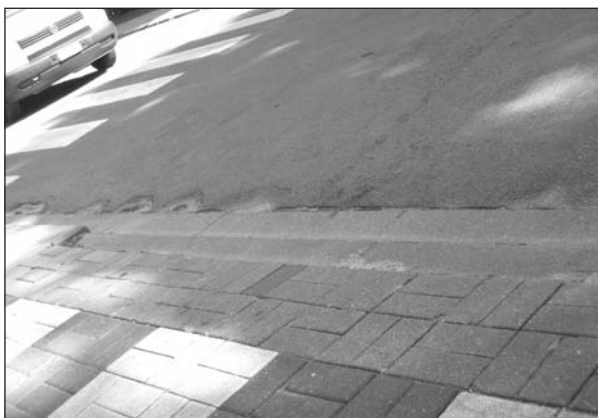
Detail aansluiting tussen straatkeien en bitumineus mengsel
