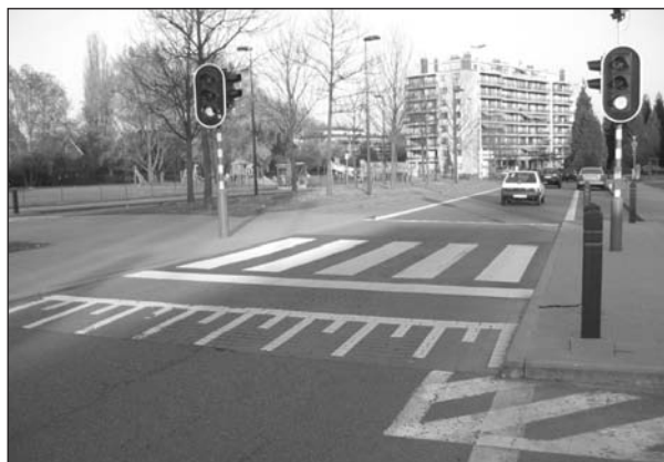
Verkeersplateau in asfalt in Sint-Lambrechts-Woluwe
