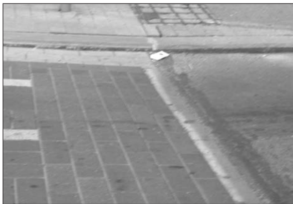
Detail: Herstelling van een aansluiting
