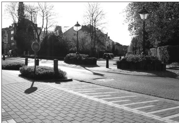
Wegverlegging door een middeneiland in Sint-Pieters-Woluwe
