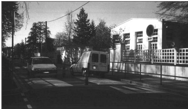
Rijbaankussens op een rijweg van 6 tot 7,40 m (Bron: Certu, Guide des coussins et plateaux, 2000)
