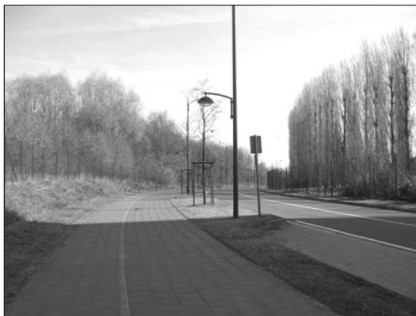
Aanleg van een fietspad in Neder-Over-Heembeek
