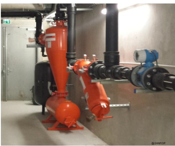
Filtre cyclonique et tamis (50 m 3 /h)
