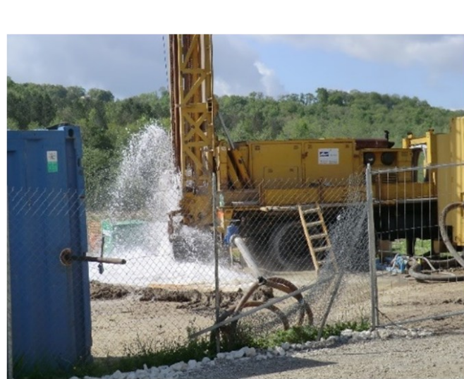
Forage du puits de production
