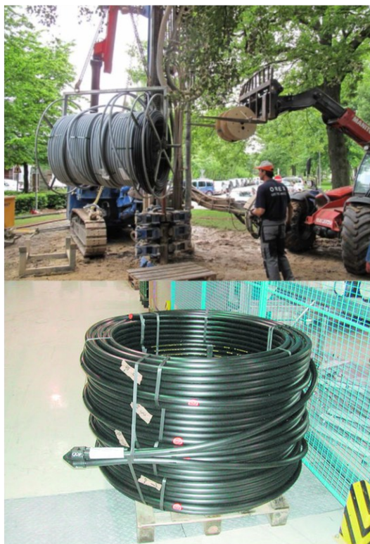
Forage & installation sonde PEHD
