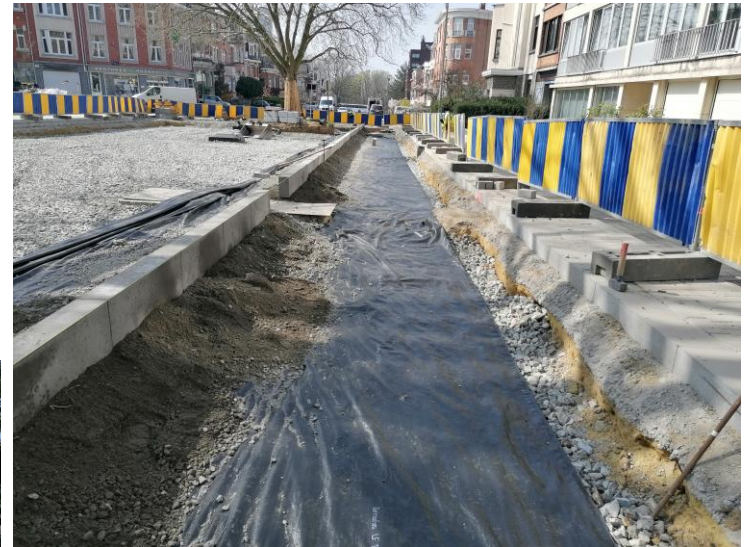
Pose des bordures et du revêtement sur la zone tampon / Plaatsing van de boordstenen en de verharding boven de bufferzone
