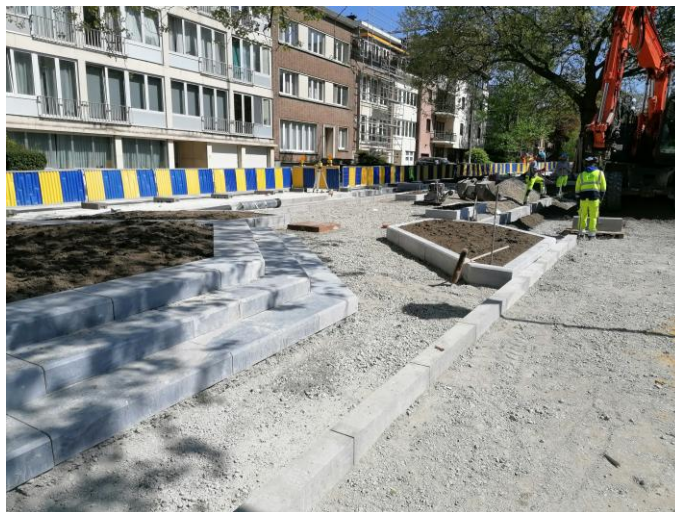
Pose des bordures et du revêtement sur la zone tampon / Plaatsing van de boordstenen en de verharding boven de bufferzone
