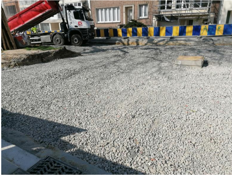
Fin des travaux de la zone tampon d'infiltration / Eind van de werken van de bufferzone
