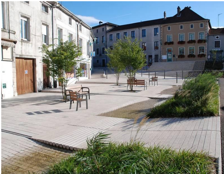
Aanleg van een openbaar plein
