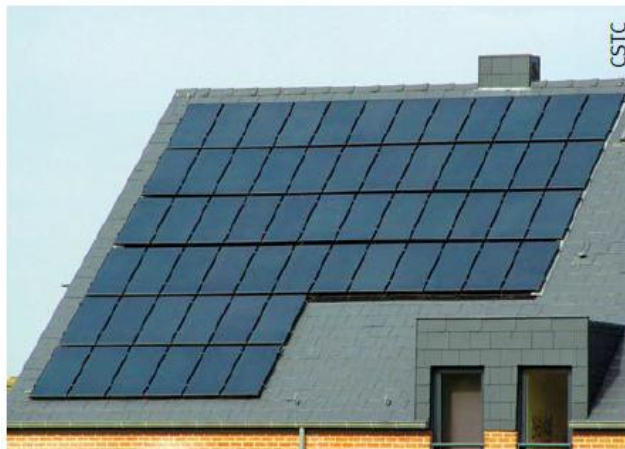
Fig. 10 Capteurs solaires photovoltaïques en semi-intégration.
