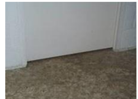
Ingekorte deur H_{\text{spleet}} \geq 5 \text{ mm}
