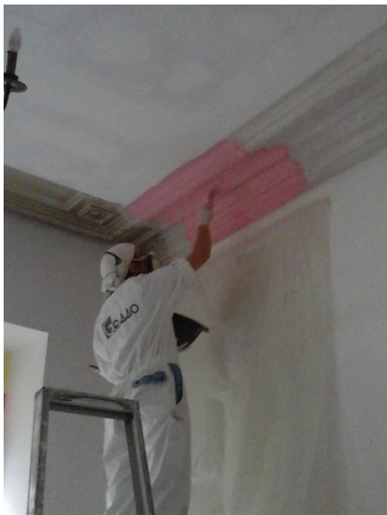
Het maken van een negatieve mal van de bestaande lijstwerk Bron: Philippe Abel
