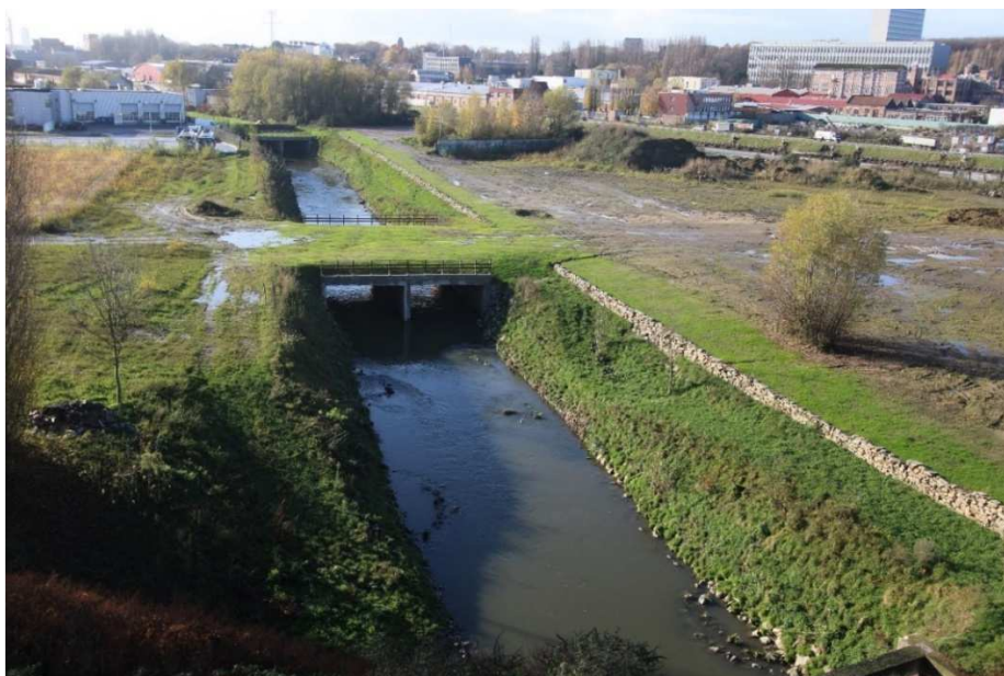
Zicht op de Zenne in het noorden van het Gewest (vlak vóór het afvalwaterzuiveringsstation Brussel-Noord). Dit stuk van ongeveer 200 meter werd eind 2021 opnieuw blootgelegd.
