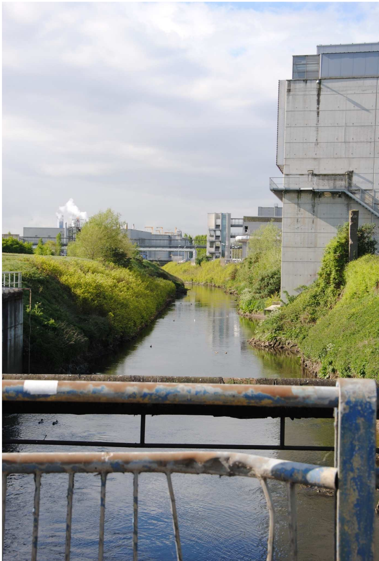
Zicht op de Zenne, aan de uitgang van het Gewest, ter hoogte van het afvalwaterzuiveringsstation Brussel-Noord. Het afvalwaterzuiveringsstation zal een centrale rol vervullen in de toepassing van de nieuwe richtlijn betreffende de behandeling van stedelijk afvalwater.
