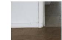
Plinthes et chambranles Loc: toutes pièces Formats: 15/70 mm Aspect: bois peint Composition: supposément sapin. Etat: moyen à bon Fixations: cloué Projet: sur parois inchangées: peinture Projet: sur parois modifiées: démontage et repositionnement si possible
