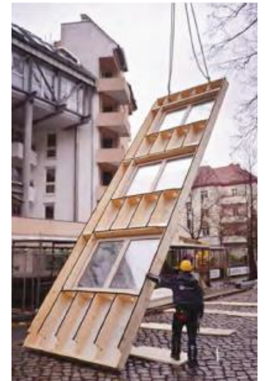
Aangebrachte modulaire gevel
