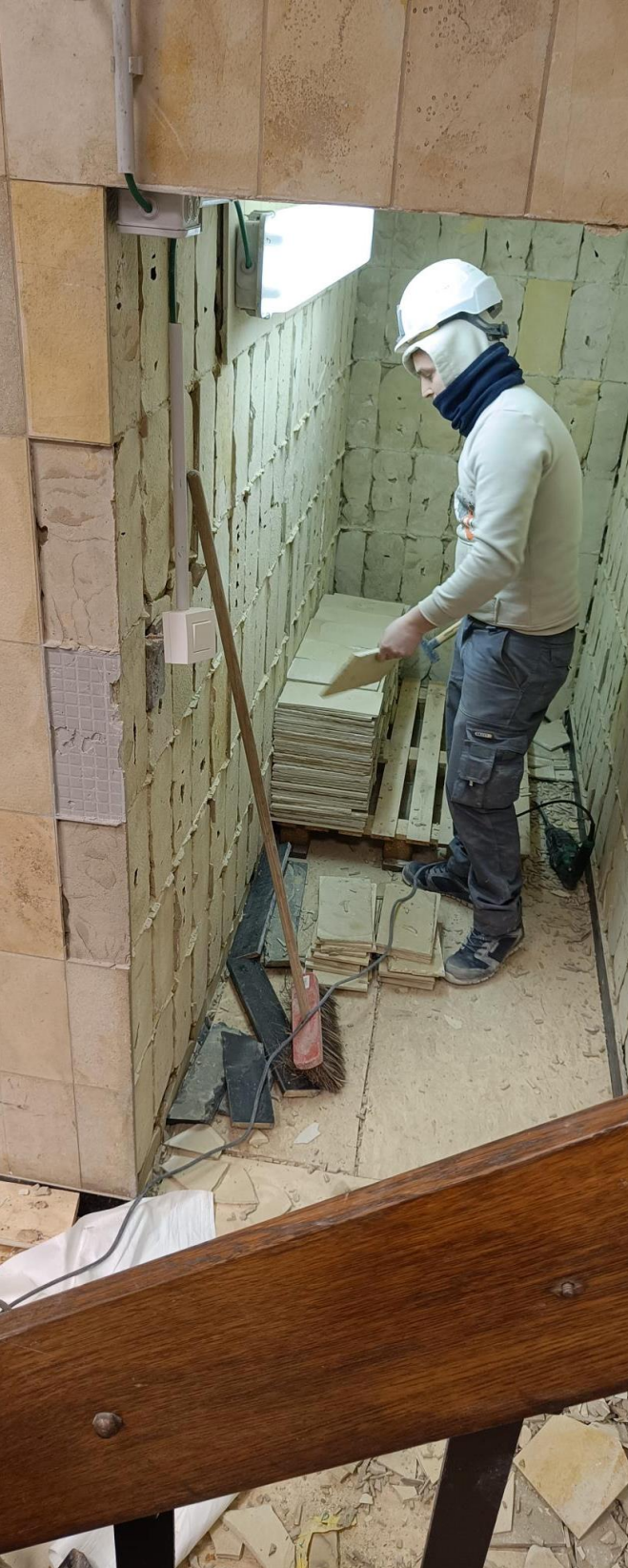
Foto's van de werf: fase van demontage en opslag van de hergebruikelementen
