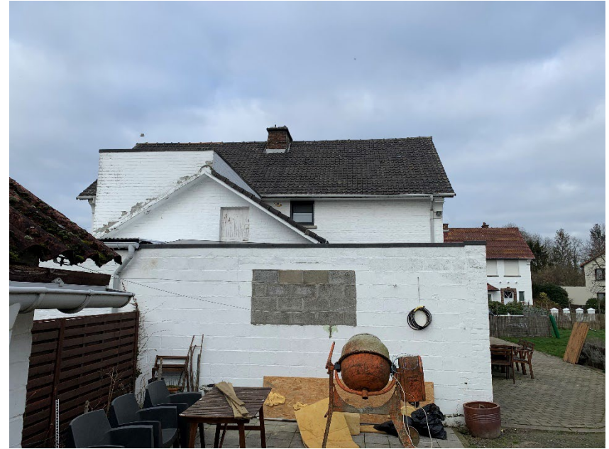
Geschilderd met afschilfering en aangebouwde delen
