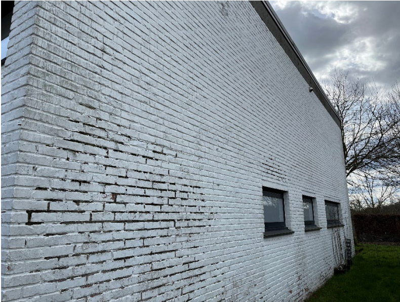
Geschilderd met afschilfering verf en algengroei
