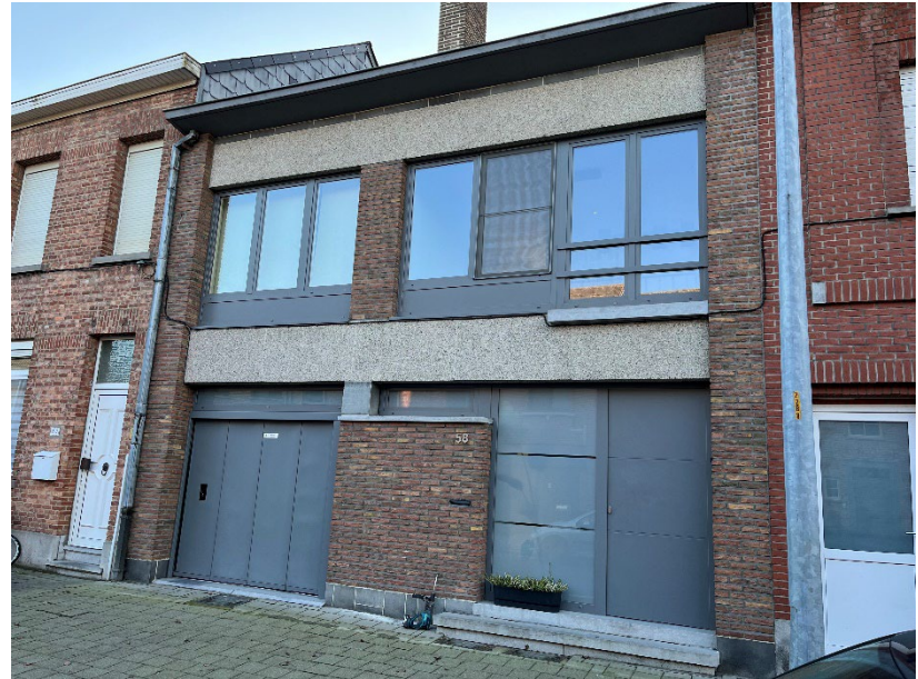
Gevel met (bijna) geen spouwmuren
