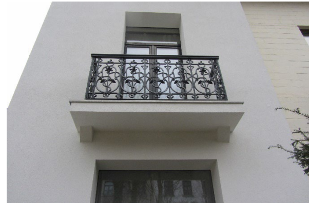
Gevel met behouden balkon - NA
