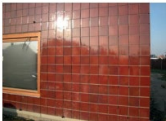
6 | Dampdichte buitenafwerking. Links: keramische tegels. Rechts: geëmailleerde baksteen.
