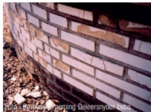
6 | Dampdichte buitenafwerking. Links: keramische tegels. Rechts: geëmailleerde baksteen.
