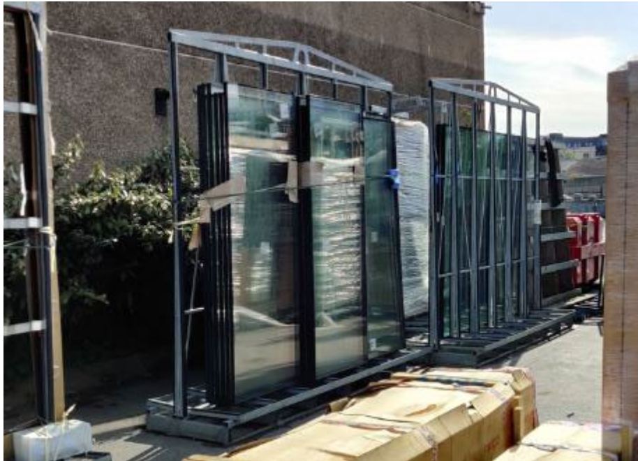
Silex-tegels afkomstig van WTC-complex opgeslagen en gereinigd (Project Zin, Befimmo) >
