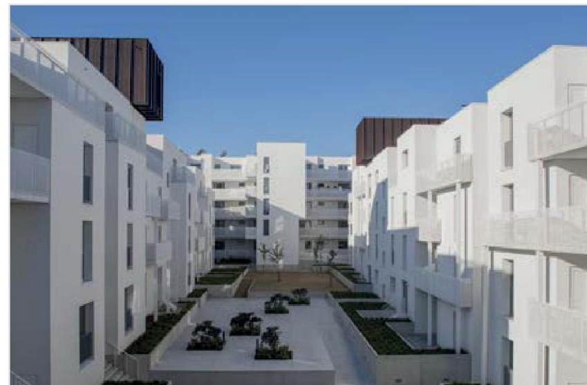
Centraal huizenblok - Fases I en II - Architecten: MDW
