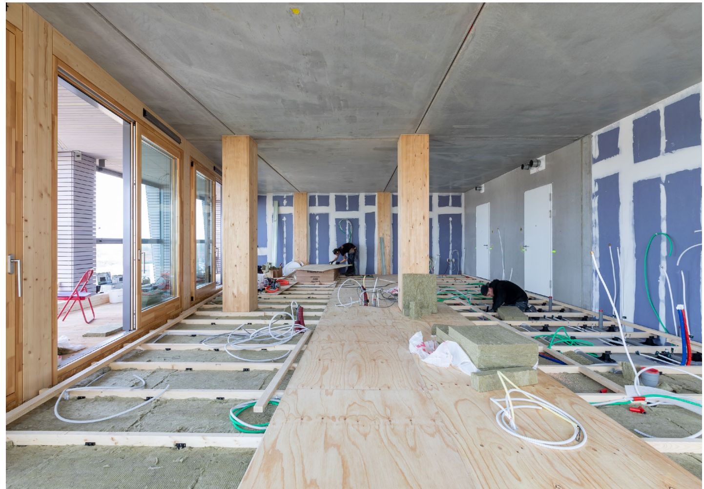
Project FRANTZEN et al architecten Top-up, Amsterdam- patch22.nl | Beeld Luuk Kramer
