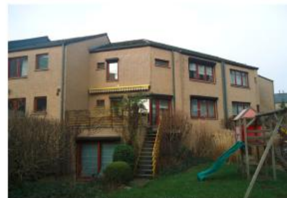
Vue arrière de la maison, à l'emplacement de la future annexe
