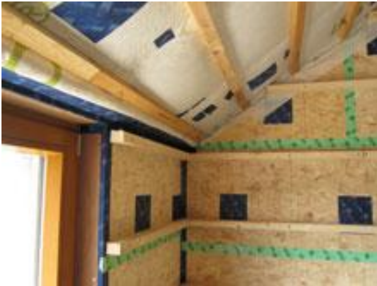
Diverse aansluitingen Bron: Buildwise
