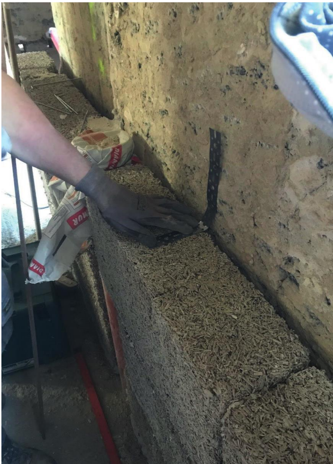
Mise en oeuvre des premiers blocs de BCC et recherche d'une solution d'accroche sur un béton plus tout jeune.
