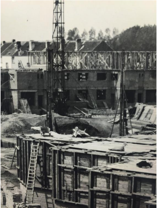
Photo du chantier / Système "Non Plus" - Circa 1926 - AAM
