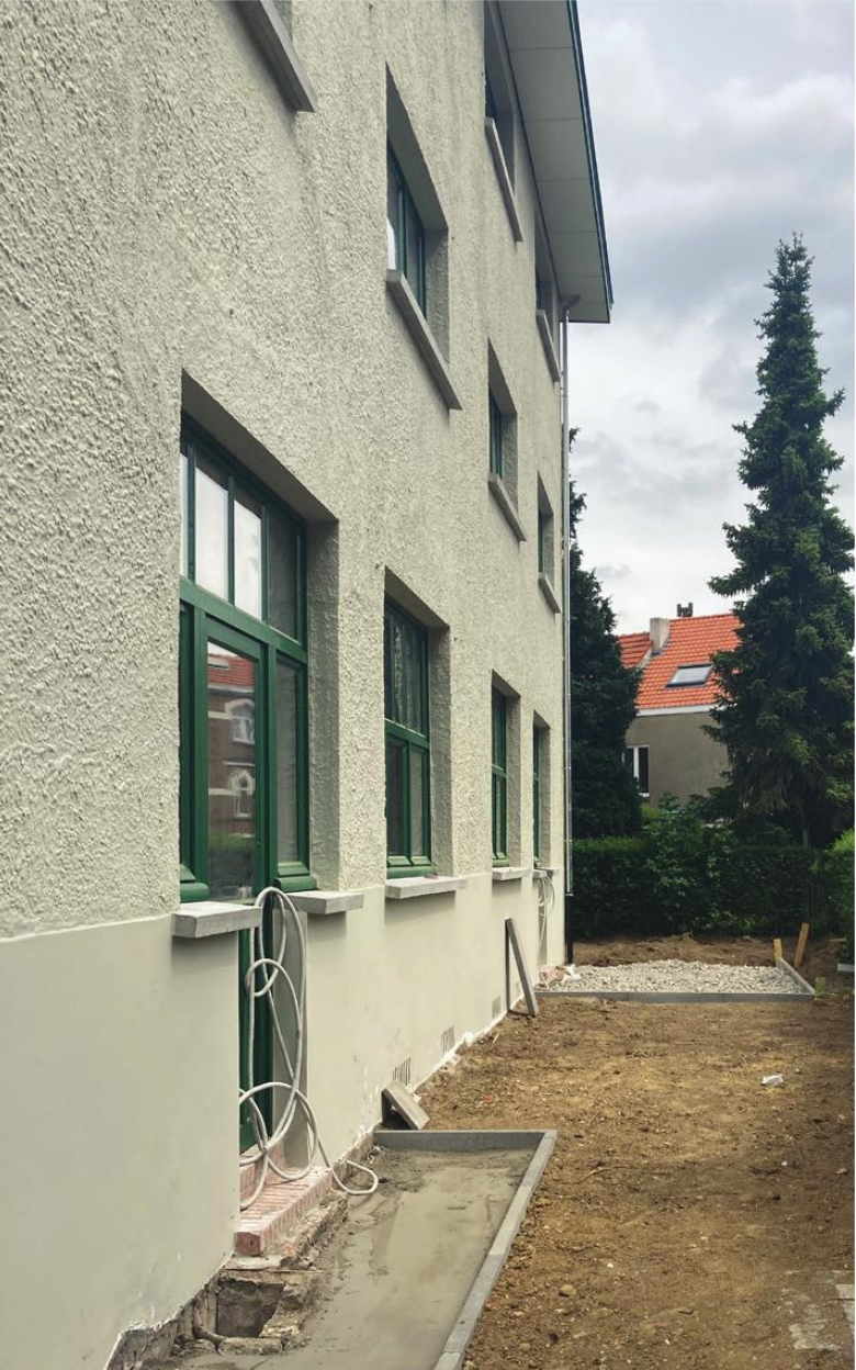
Vue du chantier en cours - rue de la Fondation 39-45
