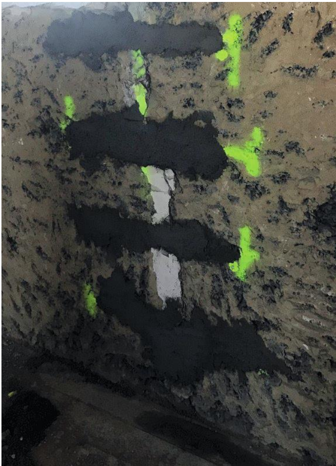
Mise en oeuvre d'agrafes ø8 mm pour reprendre les multiples fissures des murs de façades.
