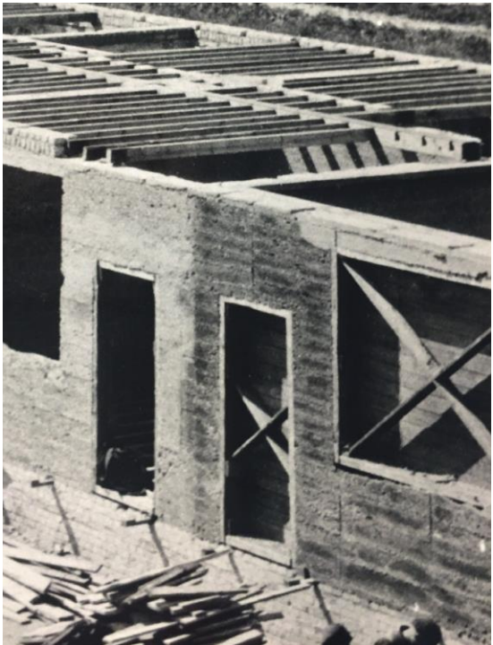
Photo du chantier / Système "Non Plus" - Circa 1926 - AAM
