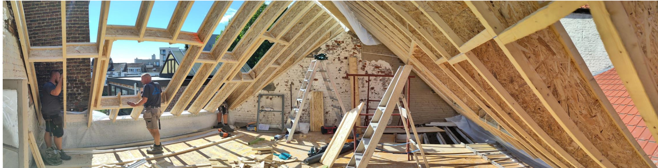
Keperwerk uit I-balken
