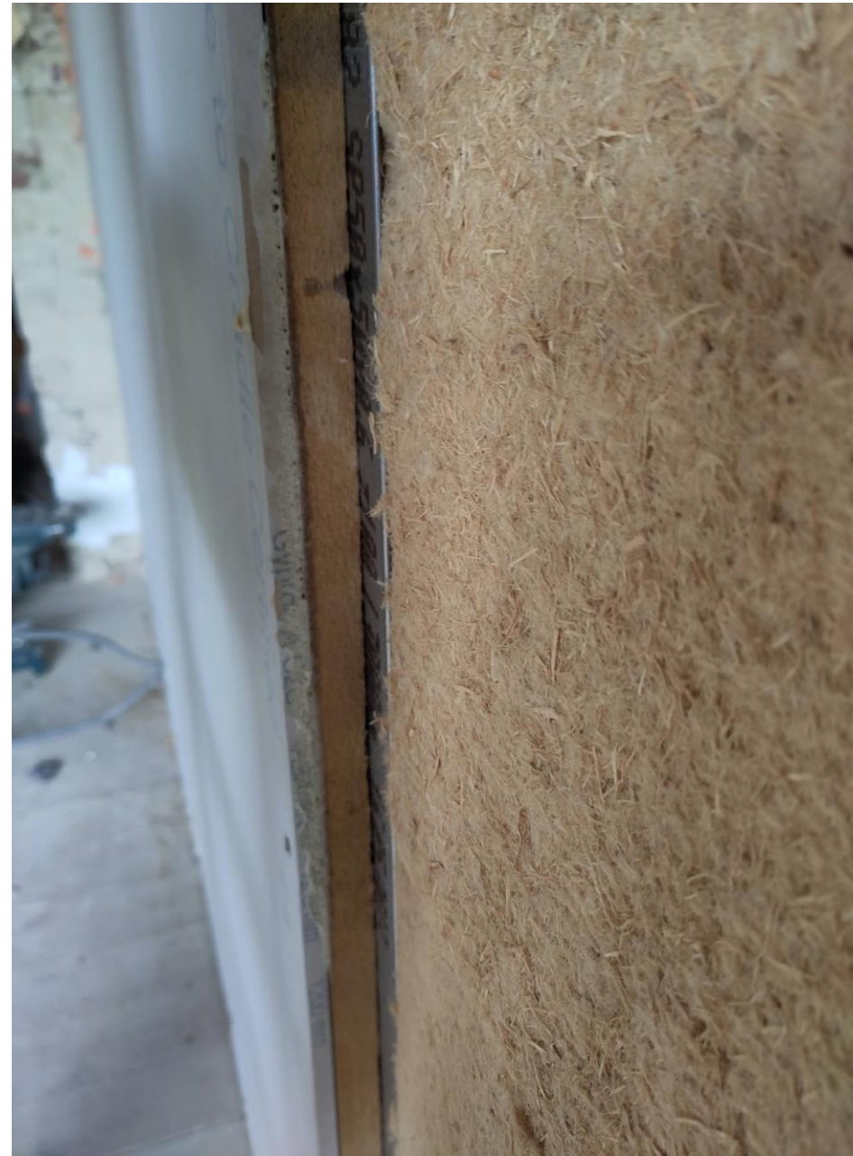
Afwerking uit sandwichplaten houtvezel/ gips-vezels
