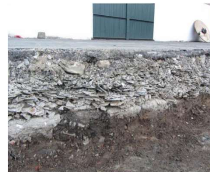
Asbeststukken in ophooglagen
